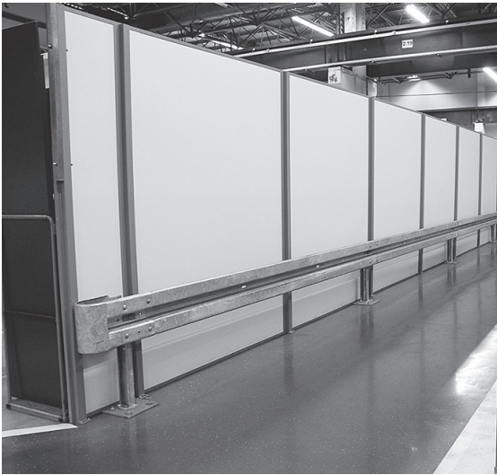
Abb. 5.3.3.2-2: Gute Abschränkung des Verkehrsweges
