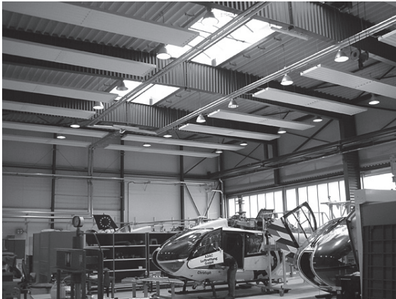
Abb. 3.1-1: Deckenstrahlplatten. (Quelle: Fa. Frenger)
