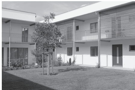
Abb. 4.2.1.1: Wohnanlage für Betreutes Wohnen in Winhöring, Foto: Wenzl + Huber, Architekten
