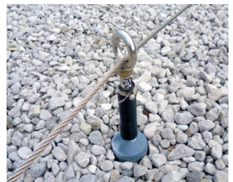
(5) Einfassung eines Anschlusses mit Klemmbride
