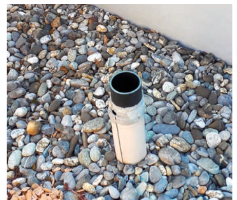
(4) Einfassung mit provisorischem Anschluss
