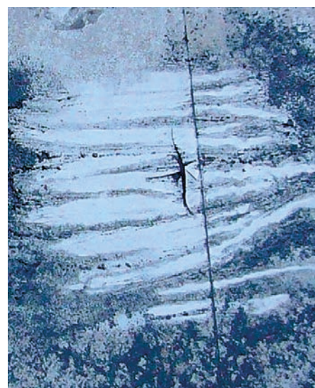
(2) Sternförmiger Hagelschaden
