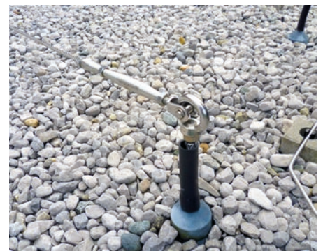
(6) Gelöste Klemmbride an einem Anschluss
