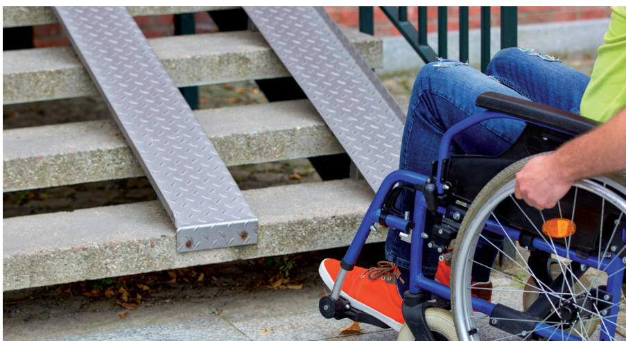
Selbstständig ist eine derartige Rampe bereits im Alltag schwierig bis kaum zu meistern. Für den Ernstfall ist dies keine sinnvolle Alternative.
