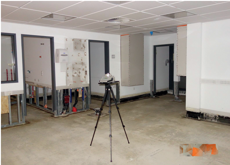
Bild 54: Probenahme der Raumluft nach abgeschlossenem Rückbau und durchgeführter Feinreinigung (Quelle: Uwe Münzenberg)
