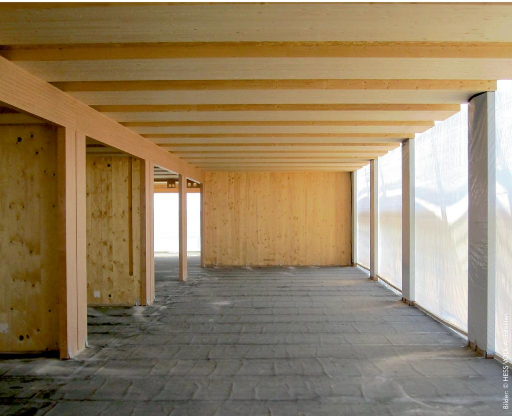
3 | Holzrohbau mit freiem Deckenrand und Deckenplatten auf Lücke
