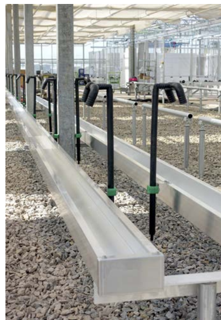
(5) Installation der Bewässerungstechnik, von der für jede Pflanzenkultur eine andere Wassermenge und -qualität bereitgestellt wird: Das erfordert passende Leitungen und Pumpen sowie unterschiedlichen Wasserdruck für Wurfregner im Freiland bzw. Handbräusen, Sprühdüsen und Flutventile der Pflanztische im Gewächshaus.
