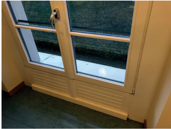
Abb. 4.6.1.1-1: Außenliegende Absturzsicherung, (Quelle: Felske)
