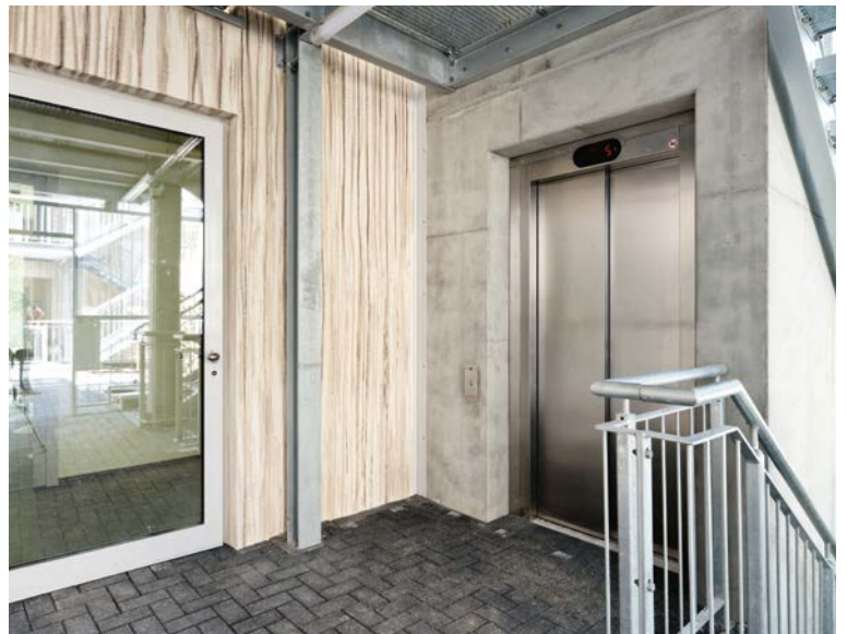
Ein Aufzug sorgt für barrierefreien Zugang.
