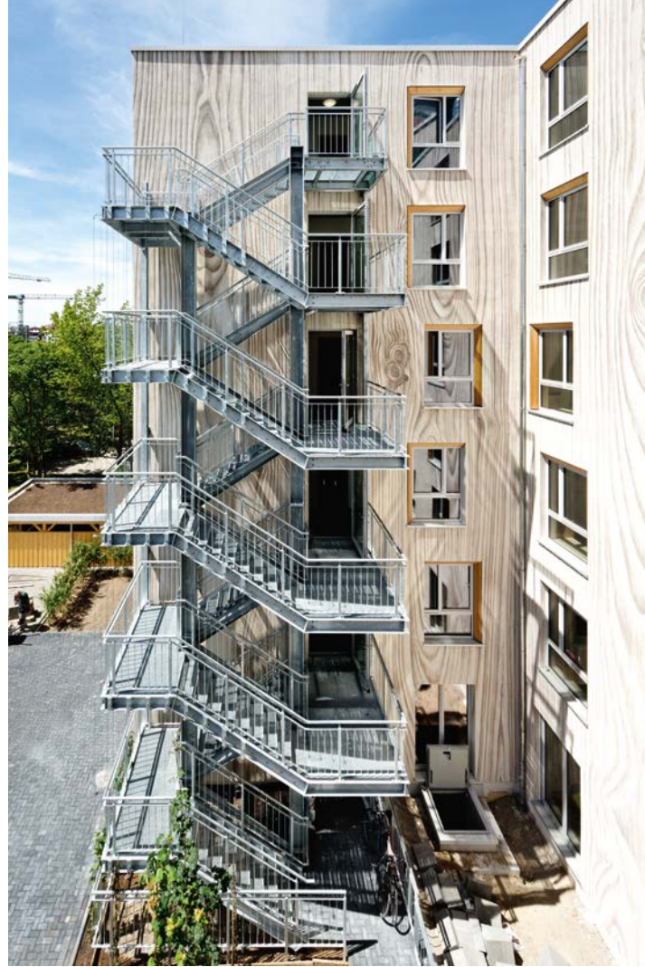
Die außenliegenden Treppen gestalten das Gebäude auf ihre Weise.
