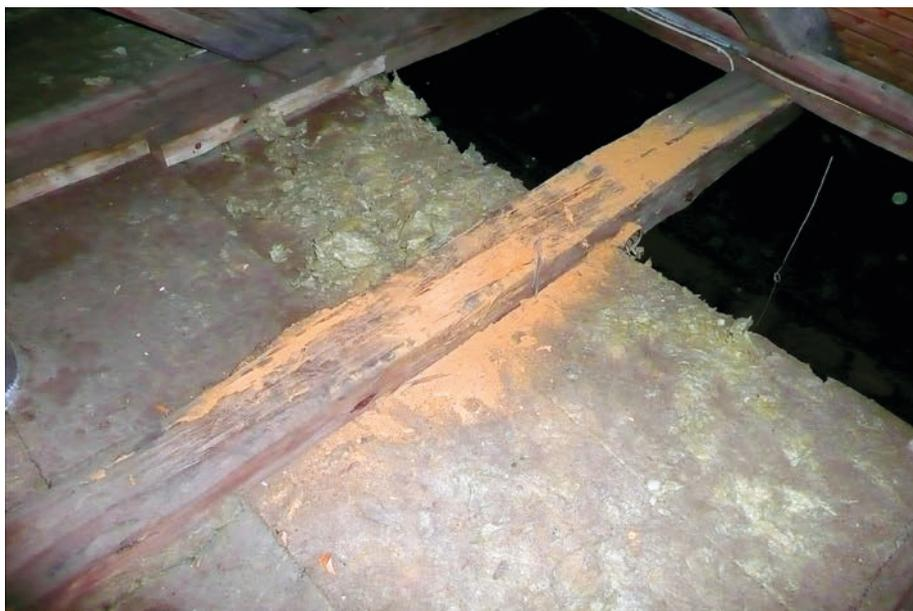
(1) Beispiel für einen stark durch Hausbockbefall geschädigten Balken
