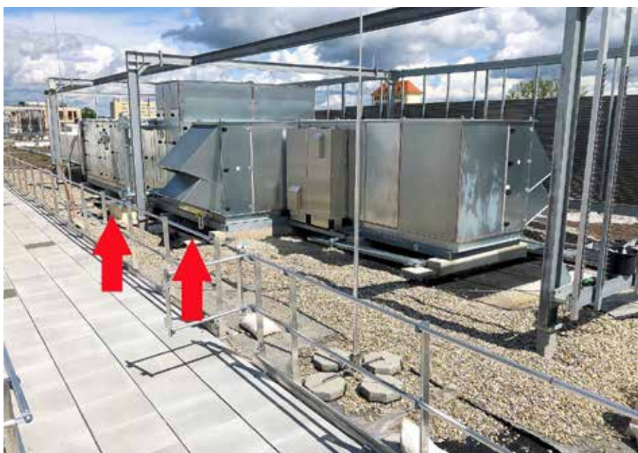
(6) Begutachtung und Bauteilöffnung an der Vorderseite der Lüftungsanlage
