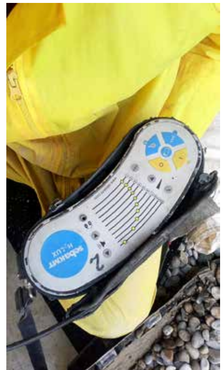
(3) Gasdetektor: Voller Ausschlag der Anzeige bedeutet, hier liegt ein Gasaustritt vor.
