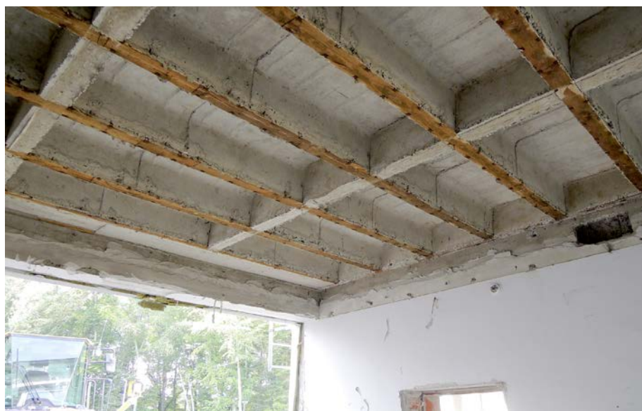
(1) Rippendecke im Bestand
