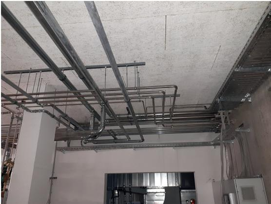
Abb. 4.2.2.1-2: Fehlende Trennung der Lüftungszentrale.
