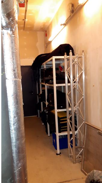
Abb. 4.2.2.1-1: Unzulässige Lagerung in Lüftungszentrale.
