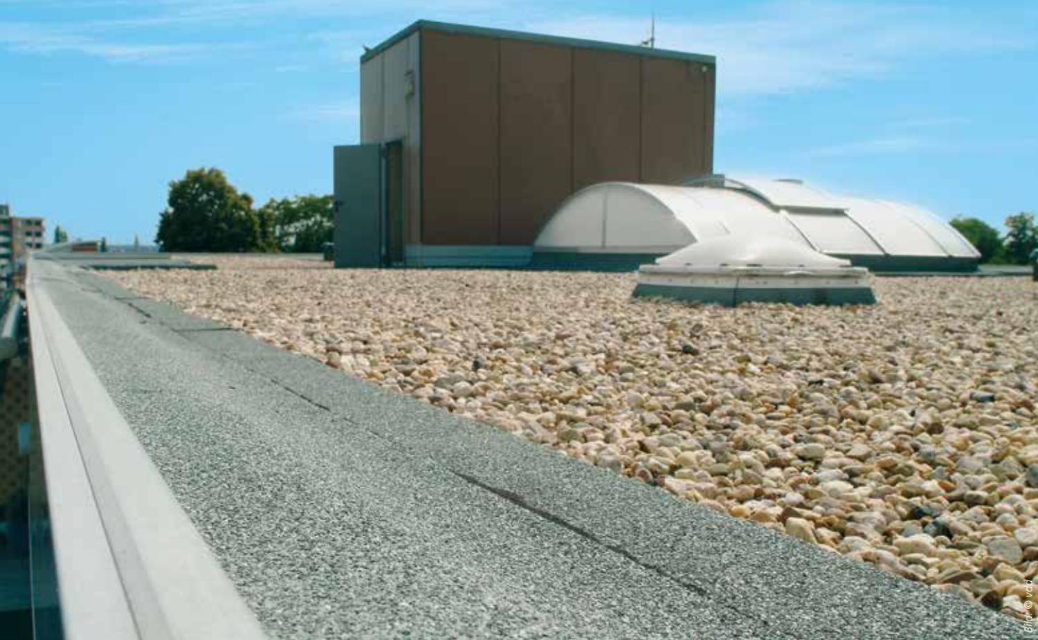
(1) Der Dachrandabschluss ist das „Ende der Abdichtung“ und verlangt deshalb besondere Sorgfalt bei der Planung und Ausführung.
