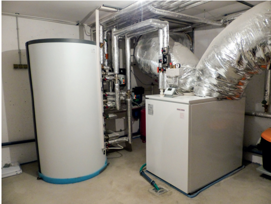
Abb. 6.1.1-2: Luft-Wasser-Wärmepumpe, Quelle: BWP
