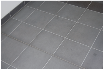
Abb 5.12.1: Weißfärbung der Feinsteinzeugfliese nach erfolgter Grundreinigung, Quelle: Cornel Klaßen
