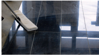
Abb 5.12.4: Reinigung der Bodenfläche mit Mikrofaserbezug, Quelle: Cornel Kläßen
