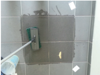
Abb 5.12.2: Aufbringen der Reinigungsflotte auf eine Testfläche, Quelle Cornel Klaßen
