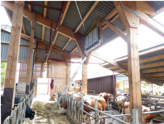
Abb. 3.7-1: Völlig ungeeigneter Montageort, Quelle: SV Schröder
