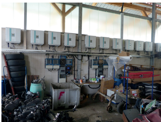
Abb. 3.7-3: Kritisches Umfeld für einen Wechselrichteranbringungsort, Quelle: SV Schröder
