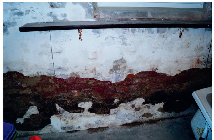
(6) Umfangreiche Feuchte- und Schimmelschäden in einem Keller-raum (Bild: © Ingrid Kaiser)
