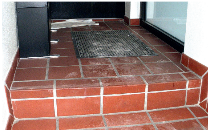
(13) Verstaubte Baustelle nach Rückbauarbeiten nach einem Wasserschaden (Bild: © Michael Thiesen)
