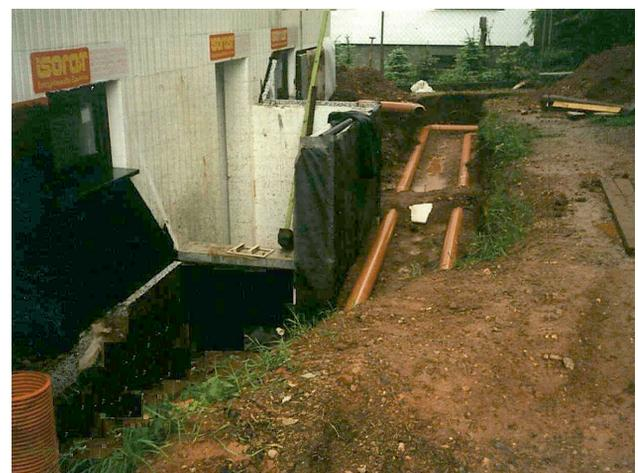
Bild 5.187: Zwei parallele Erdwärmetauscher-Rohre 2 m neben dem Fundament
