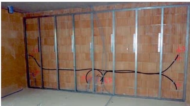
6 | Vorwandinstallation an einer Außenwand. Diese sollte eigentlich mit einem Glattstrich versehen werden.
