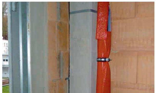
4 | Negativbeispiel: Kein Glattstrich bei Rohr- und Schachtführungen an Außenwänden / Kaminsteinen
