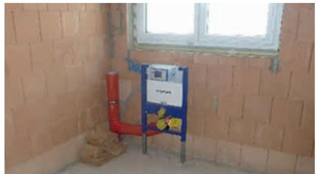
3 | Leider oft Realität: Kein Glattstrich hinter einem Spülkasten an der Außenwand.
