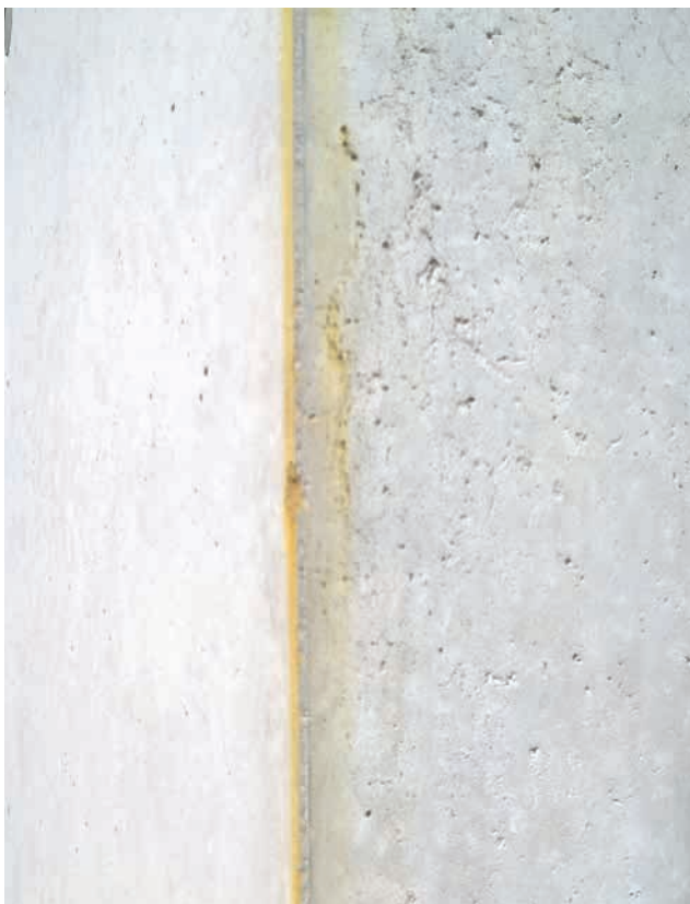
9 | Sichtbetonoberflächen mit deutlich unterschiedlicher Porosität der Wände an der Kante. Im oberen Bereich von Wänden lässt sich dies meist durch Nachverdichten reduzieren, aber nicht gänzlich vermeiden, Verfärbungen können durch zu viel Trennmittel verursacht werden.
