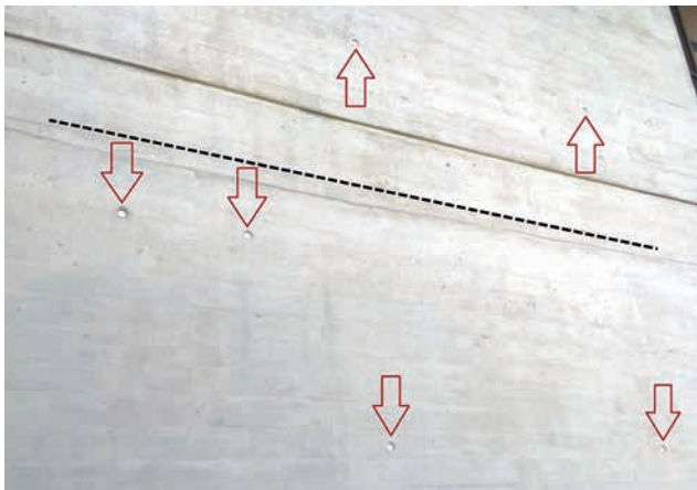
8 | Fehlerhafte Schalung mit sichtbarem Versatz (gestrichelte Linie) genügt gerade noch Anforderung SHK2, T2 bei SB 2; Anker ungleichmäßig angeordnet (Pfeile). Um dies zu vermeiden, sind entweder Vorgaben und/oder Kontrolle der Ausführung (Schalungsbau) nötig.
