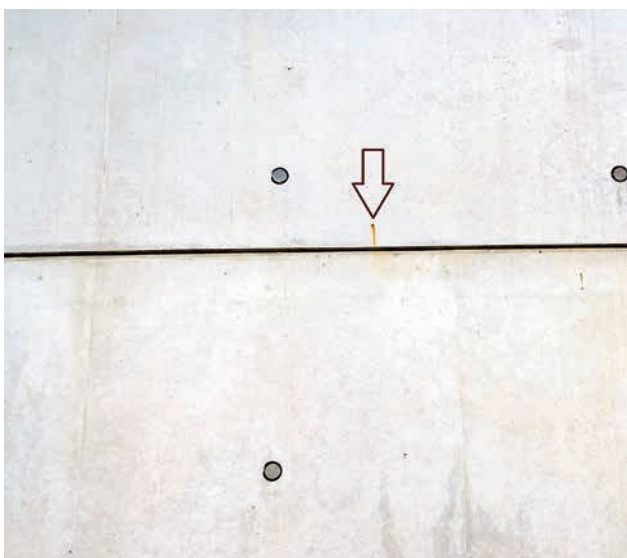
2 | Sichtbetonoberfläche mit gleichmäßig und vorbildlich verdeckten Ankerlöchern, Betonierfugen mit Leisten gut kaschieret und Fassade gut strukturiert; Rostfahnen (Pfeil) lassen sich durch Baustellenhygiene reduzieren.
