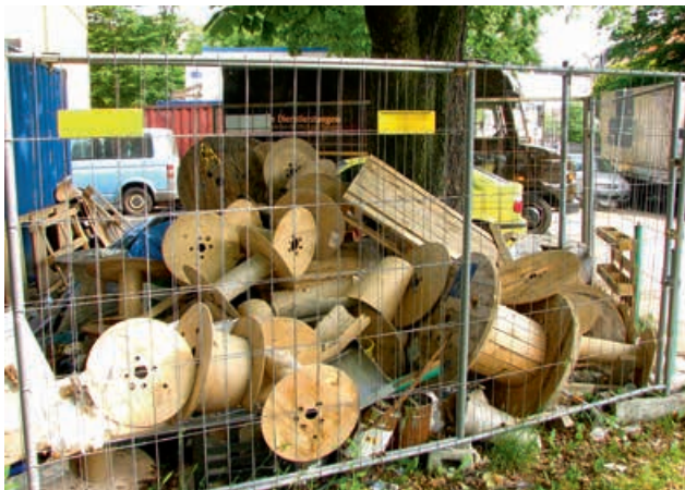
3 | So nicht! Das Zwischenlagern von Baustellenabfällen auf dem Wurzelbereich ist nicht erlaubt.
