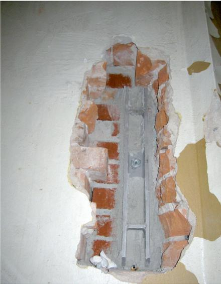
(7) Endverankerung eines waagerechten Zugankers im Mauerwerk
