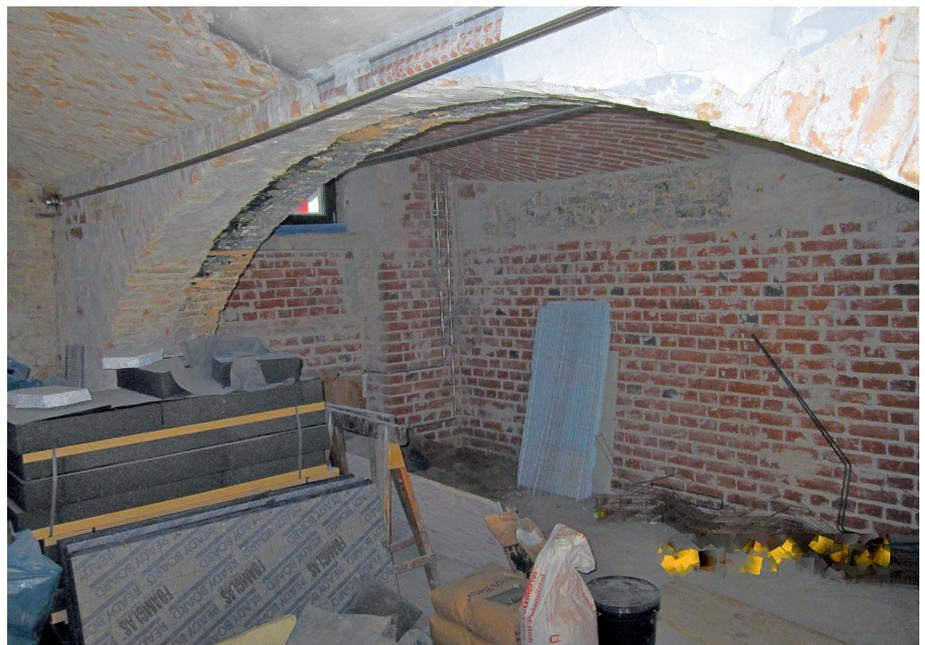
(9) Geteiltes Zugankersystem eines weit gespannten Gurtbogens mit Traversen-Endverankerung im Gurtbogen
