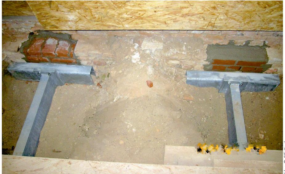
(8) Druckstäbe hinter dem Endfeld einer gerissenen Kappendecke zur Aufnahme von Gewölbeschub-Anteilen
