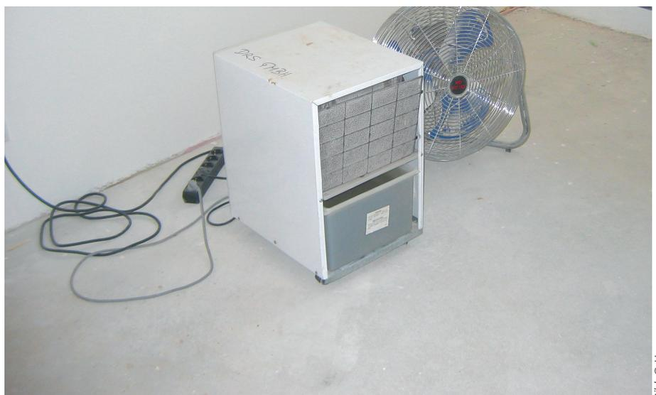
(2) Kondensationstrockner mit Ventilator
