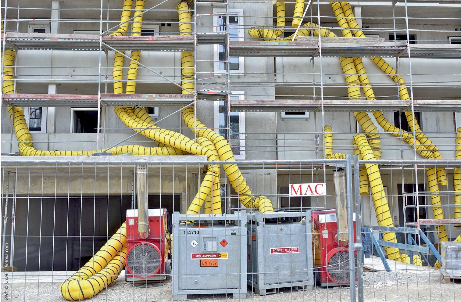
(1) Die technische Bautrocknung von Neubauten ist heute Stand der Technik.
