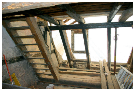
(1) Dachgeschossausbau eines denkmalgeschützten Wohnhauses
