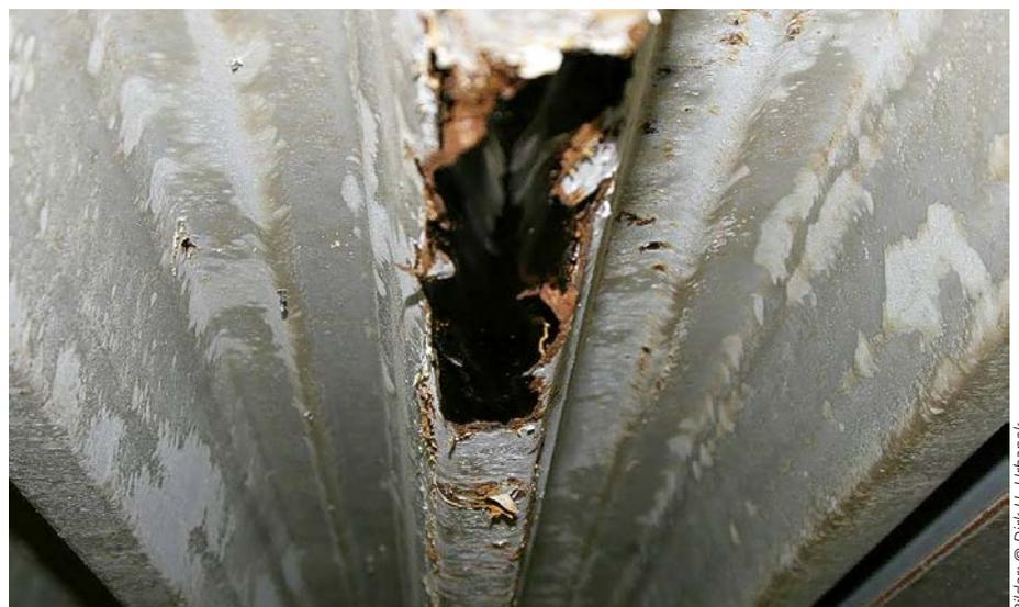
(2) Dünnwandige Querschnitte sind besonders durch Durchrosten gefährdet. Das verbleibende Tragvermögen des trapezprofilierten Querschnitts strebt gegen null.
