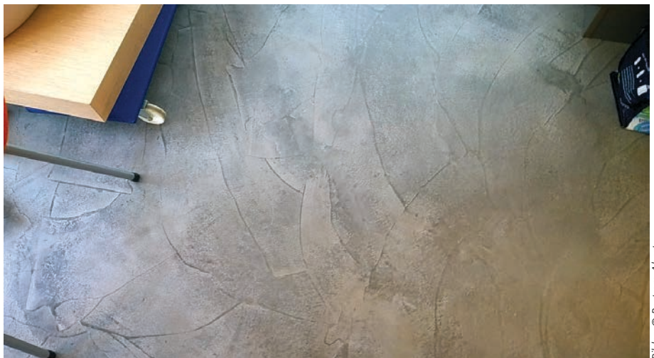
(2) Sehr stark strukturierter Boden in grober Spachteltechnik (Privatwohnung)
