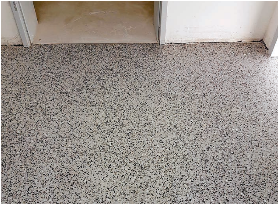
(5) Fertiger Terrazzoähnlicher Boden ca. 6 mm dick, mineralisch gebunden
