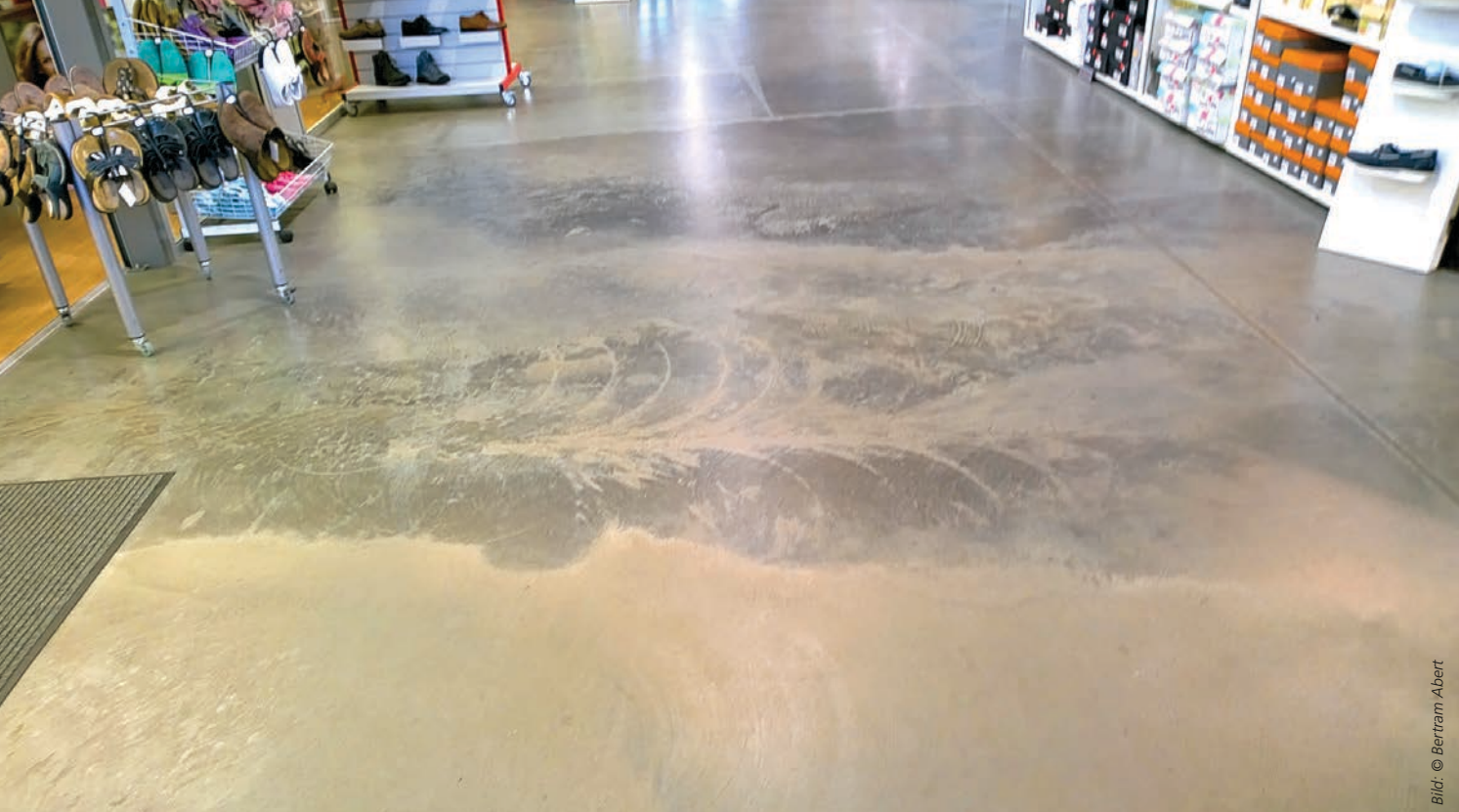
(1) Flügelglättung eines Sichtestrichs, Farbunterschiede und deutliche Glättspuren
