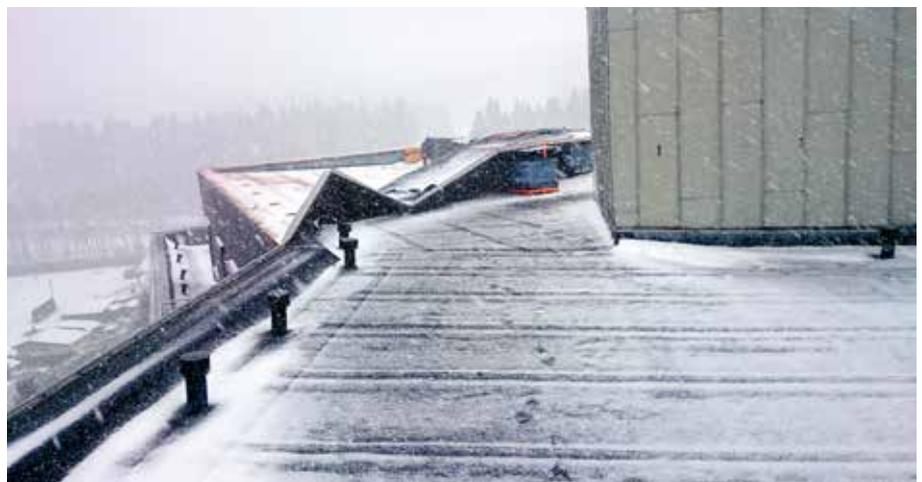
(2) Sturmschaden an einem Flachdach: Die bituminöse Abdichtung des Flachdachs wurde in den Rand- und Eckbereichen nicht ausreichend fixiert. Der Wind löste die komplette Abdichtung samt Attikaprofilen von der Unterkonstruktion.
