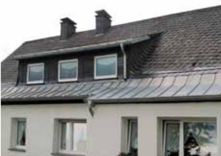
(7) Zinkeindeckung im Traufbereich: Die alte Eindeckung aus Kunstschiefer konnte den auftretenden Eismassen nicht standhalten. Da eine Sanierung des gesamten Daches für den Hausbesitzer ausschied, wurde im Traufbereich eine Doppelstehfalzdeckung aus Zinkblech montiert.
