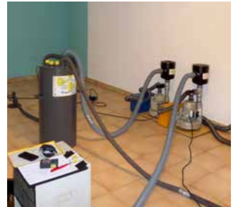
(4) Trocknungsmaßnahme über Vakuum-pumpen, Luftentfeuchter und Ventilator zur Querlüftung
