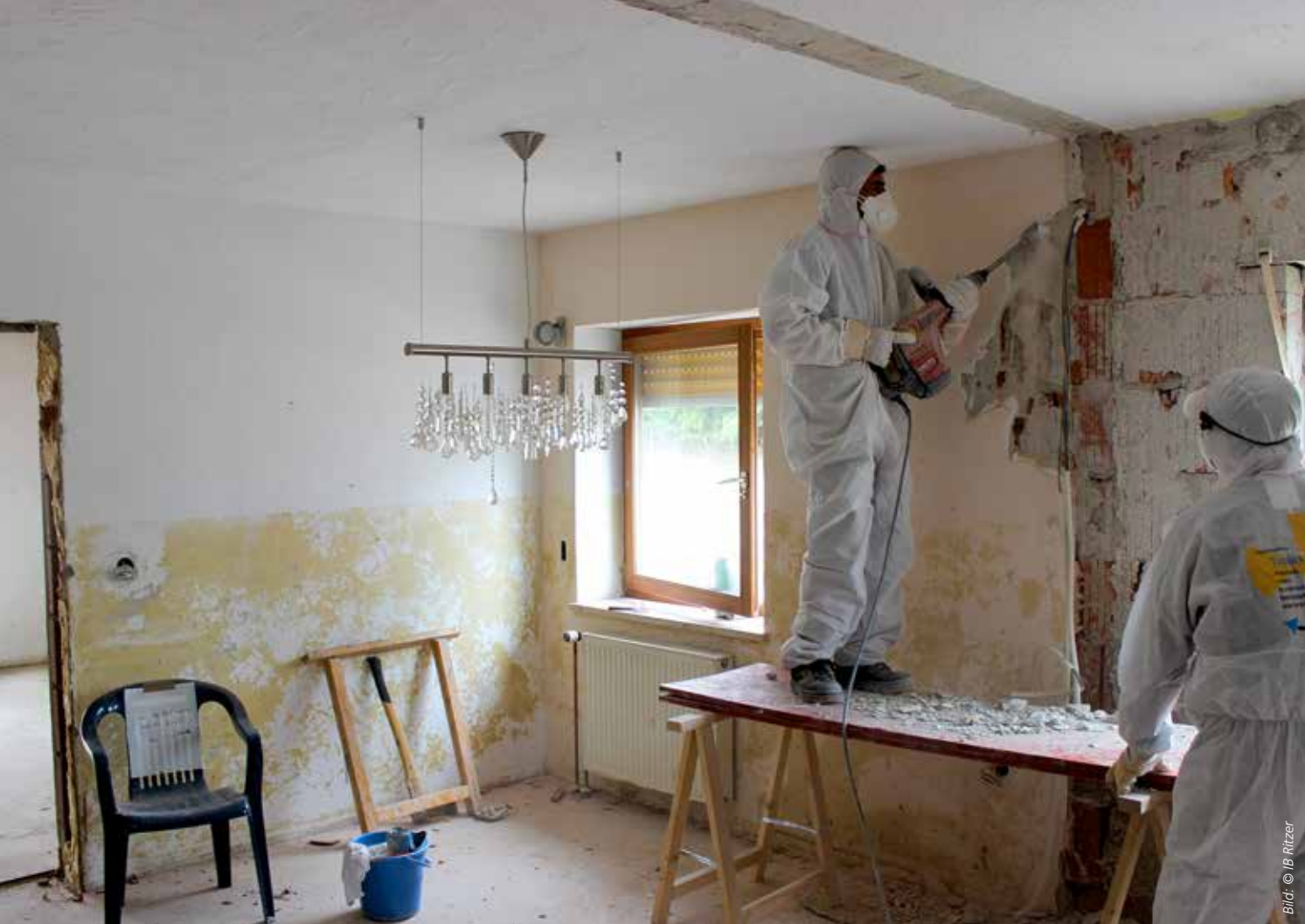
(1) Schadensanierung infolge von Hochwasser, hier: Abnehmen des betroffenen Putzes
