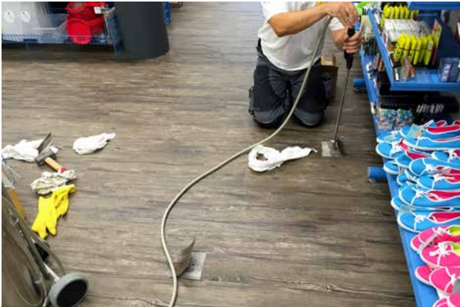
(3) Einbringen des Spezialschaums in die für die Trocknung gesetzten Bohrlöcher zur Desinfektion der Estrichdämmschicht
