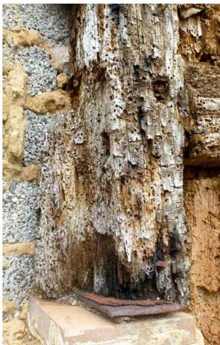
(4) Fachwerkhölzer, insbesondere hinter Verkleidungen, sollten auf Holzschäden und Tragfähigkeit geprüft werden.
