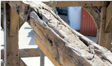
(4) Ein durch Feuchte völlig geschwächter Eichendeckenbalken aus dem oberen Stockwerk mit Befall mit Schadinsekten; die Tragfähigkeit war nicht mehr gegeben.
