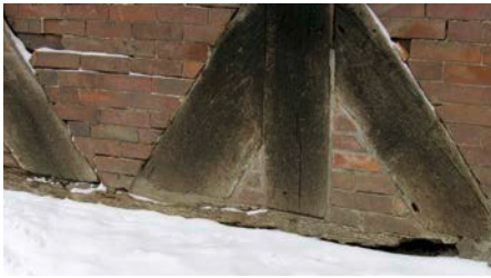
(3) Die Eichenschwelle ist durch ständigen Feuchtigkeitskontakt vollständig verrottet.
