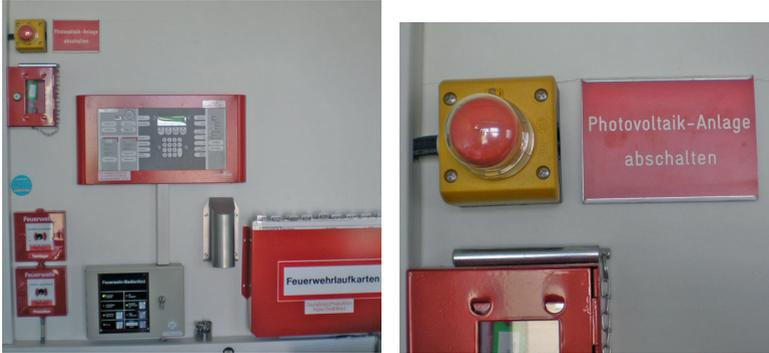
Abb 4.8.10: Zentrale Abschaltung, Quelle: VGH Versicherungen
