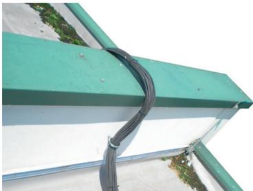
Abb 4.8.2: Ungeschützte Kabelführung über eine Brandwand, Quelle: VGH Versicherungen
