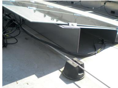
Abb 4.8.7: Demontierte Fangeinrichtung,
