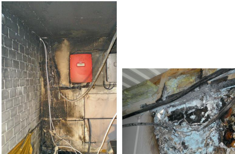
Abb 4.8.1: Brandschäden verursacht durch PV-Anlagen, Quelle: VGH Versicherungen
