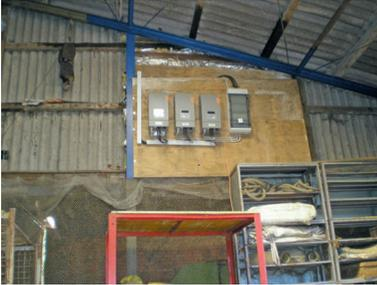
Abb 4.8.14: Unzugängliche Wechselrichter,
