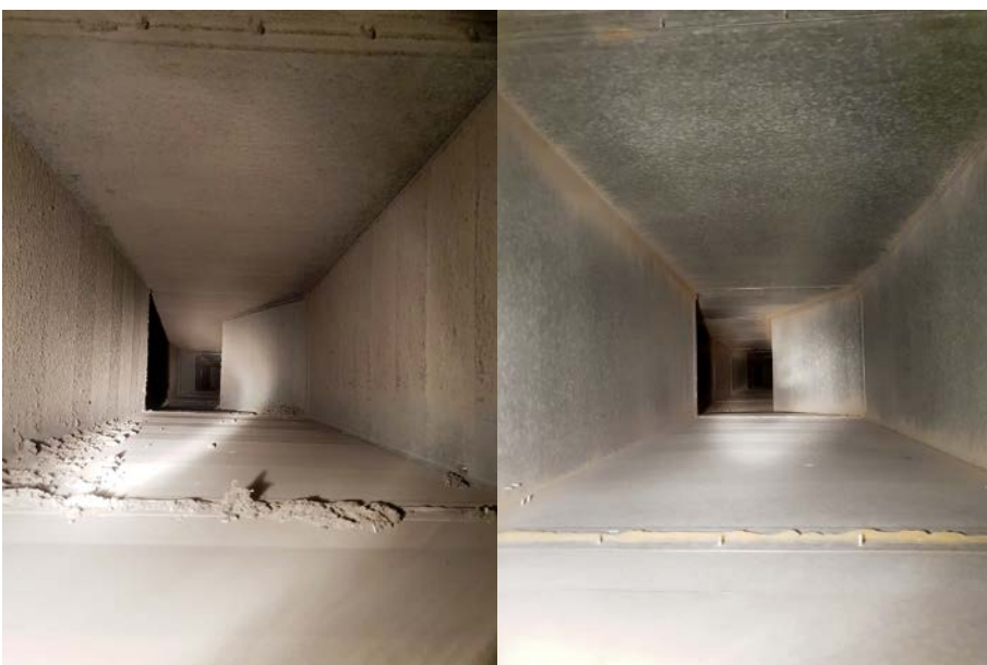
(1) Luftkanal vor (links) und nach (rechts) der Reinigung: Eine regelmäßige Reinigung ist das A und O, um Ausfälle von RLT- und Lüftungsanlagen zu vermeiden.
