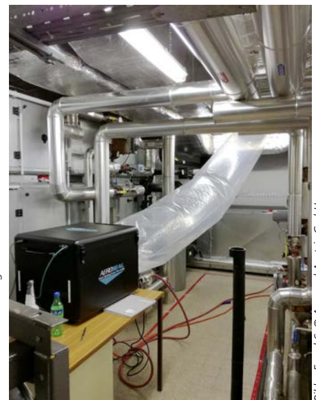
(6) Abdichtung des Luftleitungssystems bei der EBEWE Pharma mithilfe des AeroSeal-Verfahrens
