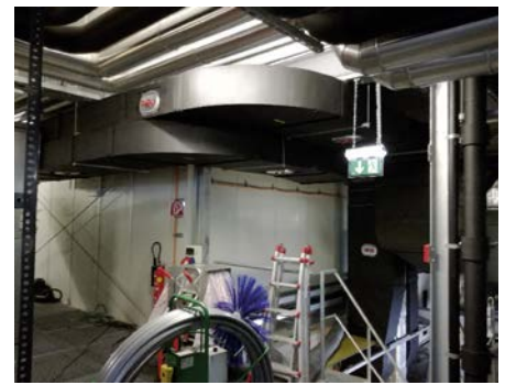
(5) Vorbereitung der Reinigung des Luftleitungssystems bei der EBEWE Pharma
