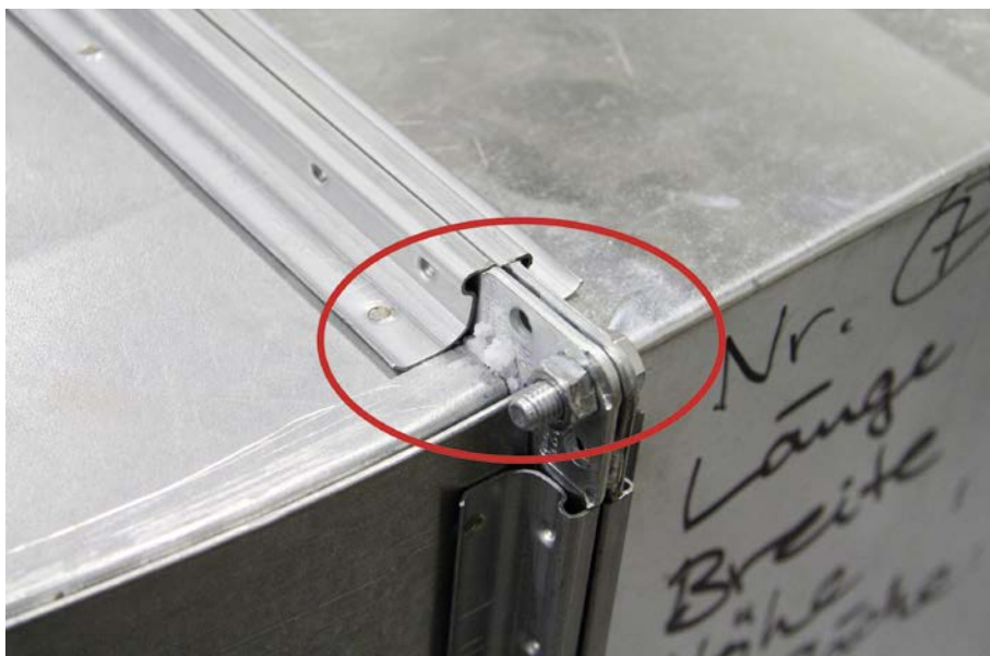
(7) Mit dem AeroSeal-Verfahren abgedichtete Leckage
