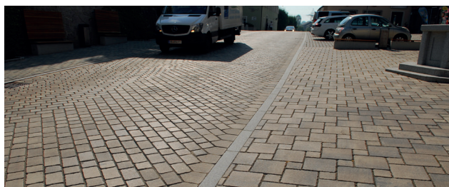
(16) Betonsteine unterschiedlicher Formate, in der Fahrbahn diagonal verlegt. Diagonale und Formatwechsel wirken schalltechnisch günstig. Die relativ breite Fuge ist ein Tribut an das gewünschte optische Erscheinungsbild, regt aber die Schallentstehung in einem sensiblen Frequenzbereich an. (Bild: © Weissenböck – www.steine.at)
