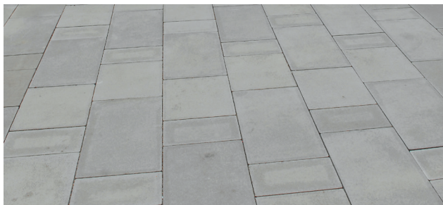
(15) Betonplatten im Reihenverband mit Steinen unterschiedlicher Formate und kleiner Fuge für schmalen Fugenspalt an der Oberfläche erzeugen eine ebene Oberfläche mit geringer Reifenanregung. (Bild: © Weissenböck – www.steine.at)
