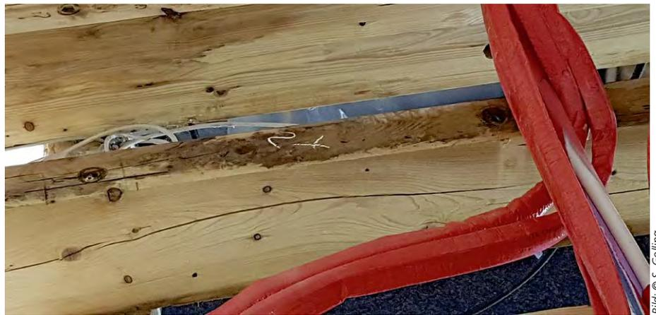
(3) Schwundriss an einem Deckenbalken nach einem Wasserschaden und anschließender Trocknung: Der Riss folgt der Faserabweichung.
