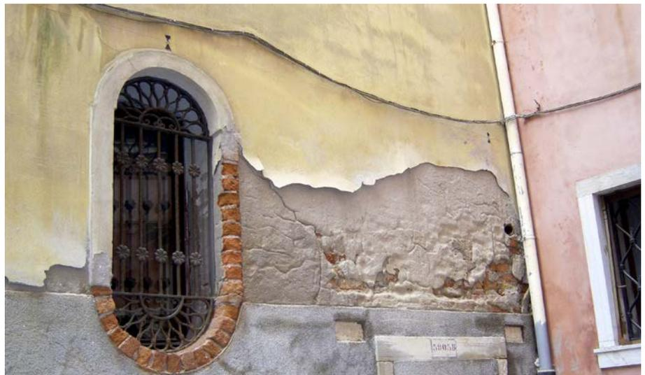
(5) Aufsteigende Feuchte hinter dichtem Zementputz
