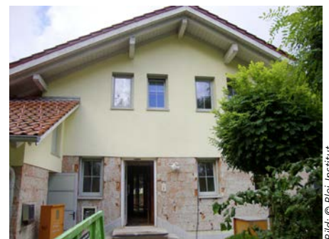
(1) Gebäudeerhaltend: Durchführung von Sofortmaßnahmen
