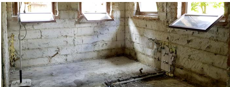
(2) Entkernungsmaßnahmen im Keller
