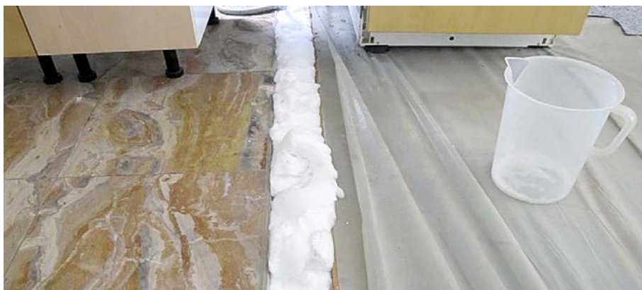
(7) Schaumverfahren auf Wasserstoffperoxidbasis
