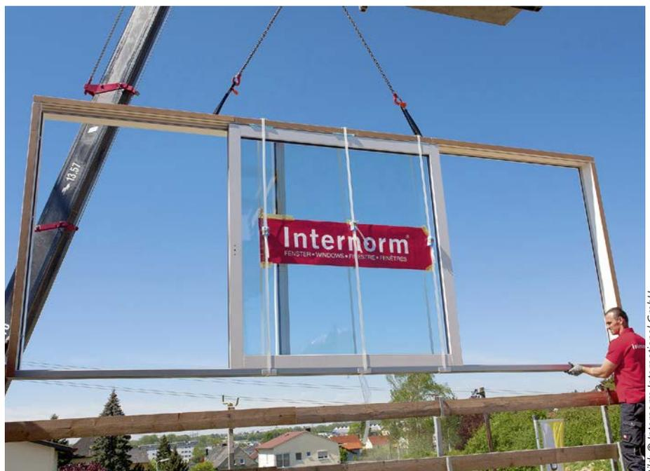
(6) Lastfall Krantransport mit direkter Lasteinleitung der Eigengewichte durch Zugentlastungen und entsprechende Wahl der Anschlag- und Flügelposition
