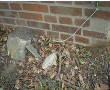
Abb. 4.5-4: Behelfsmäßige Erdungsanlagen,
