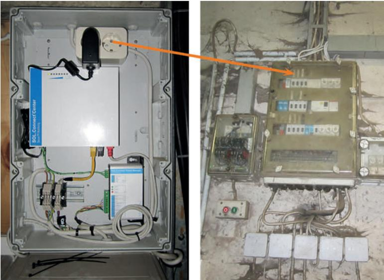
Abb. 4.5-6: Übertragungseinrichtung mit Versorgung aus der Gebäudeinstallation,
