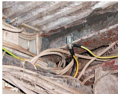
Abb. 4.5-5: Behelfsmäßige Erdungsanlagen,
