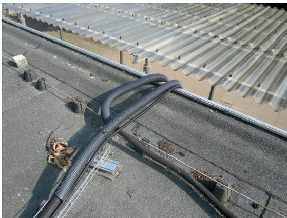
Abb. 4.5-5: Trennungsabstand nicht eingehalten, Beispielbild 1, Quelle: VGH Versicherungen
