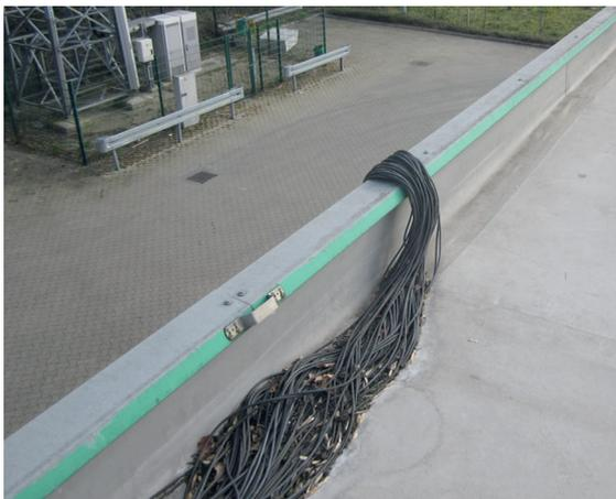
Abb. 4.5-6: Trennungsabstand nicht eingehalten, Beispielbild 2, Quelle: VGH Versicherungen
