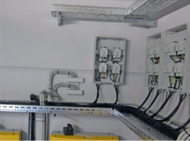
Abb. 4.5-3: Ableitung parallel zu geschützten Stromkreisen geführt,
