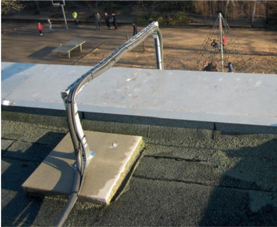
Abb. 4.5-9: Trennungsabstand eingehalten, Quelle: VGH Versicherungen
