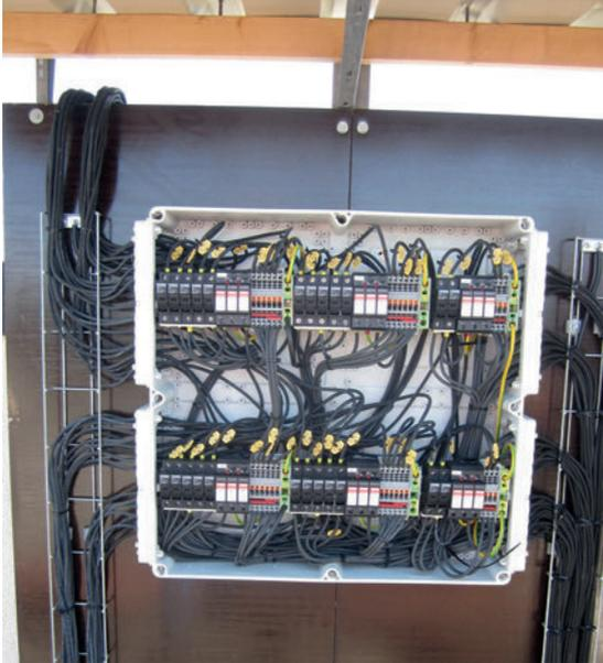
Abb. 4.5-11: Kabelführung Überspannungsschutz mangelhaft,
